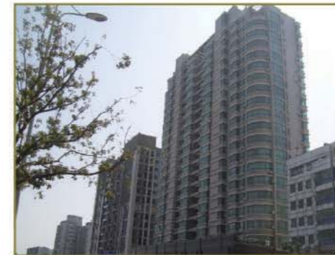
行政办公中心 Administrative office
